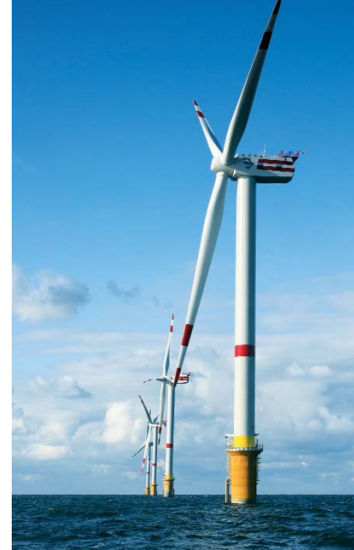
Offshore-Anlage: Die Zukunft der Windenergie in Deutschland liegt an der Küste.
