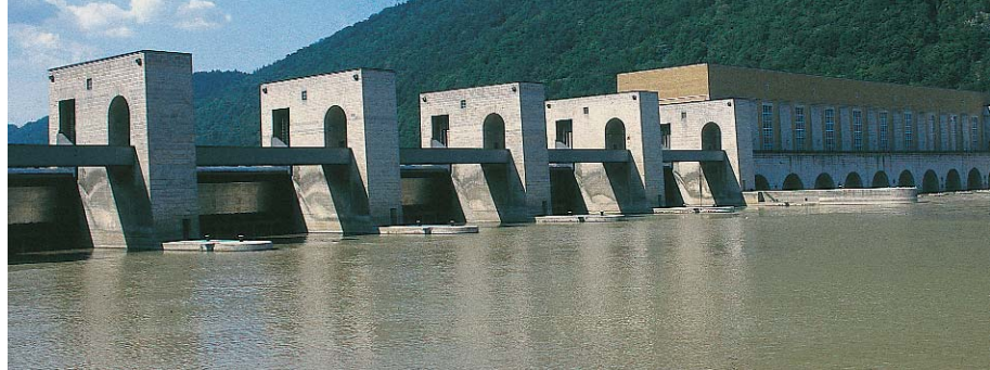
Alles im Fluss: Laufwasserkraftwerke dienen v. a. der Erzeugung von Grundlaststrom.
