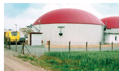
Gülle und Reststoffe geschickt genutzt: In Biogasanlagen wird aus Abfall Energie.
